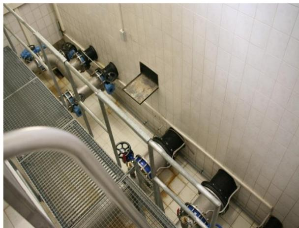
rechts: Schieberkammer (Zulauf-
